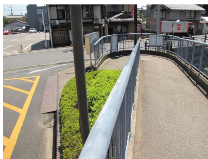
駐車場 スロープ(上からの写真)
