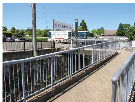
駐車場 スロープ(下からの写真)
